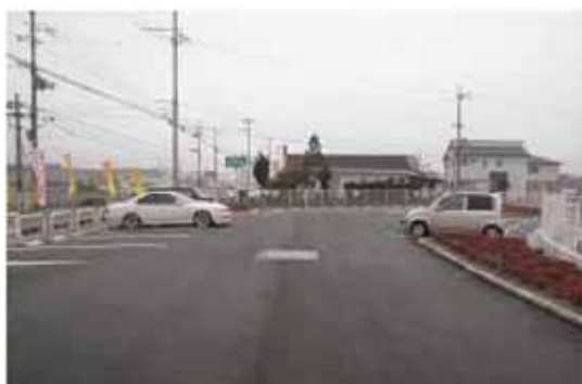
図 5-3 設置した指定雨水貯留施設
