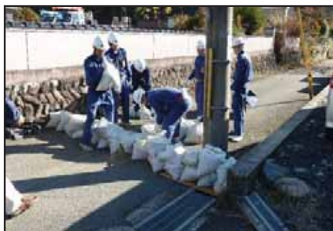
宍粟市 土嚢積み
