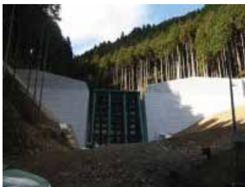
図 5-18 計画地域の砂防堰堤(大榎川)
