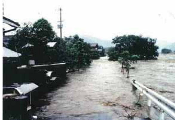
宍粟橋右岸浸水状況(宍粟市山崎町)
