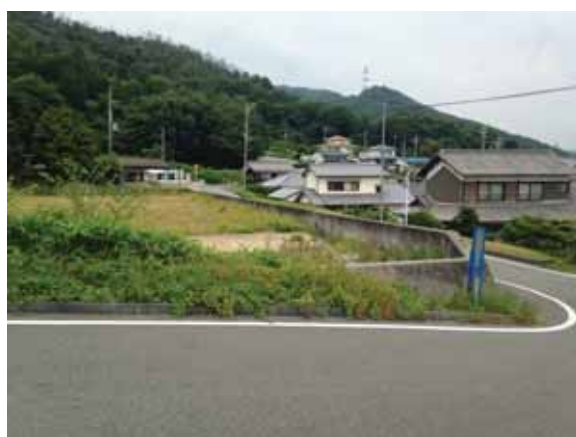
スポーツ公園内ゲートボール場での雨水貯留 (福崎町)
