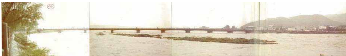
洪水中の龍野橋の状況(たつの市)
