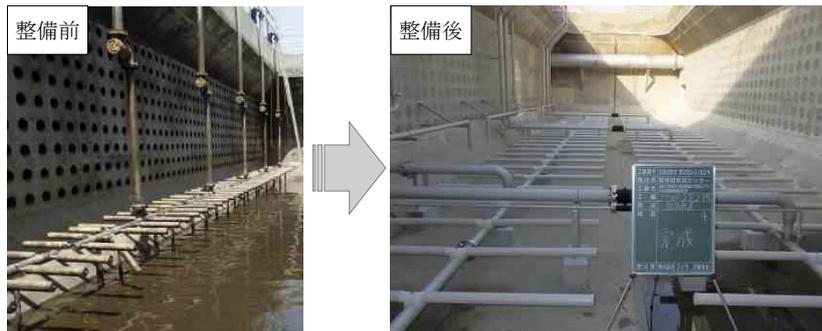
老朽化した散気装置を更新
