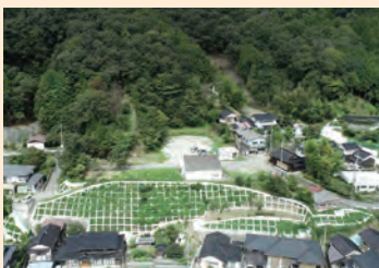
急傾斜地崩壊対策工事 (宍粟市山崎町五十波)
