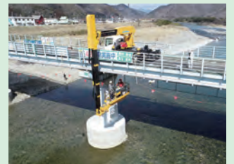
新香橋耐震・補修工事 (たつの市新宮町下野)
