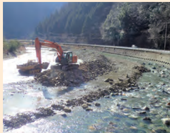
千種川堆積土砂撤去工事 (佐用町船越)
