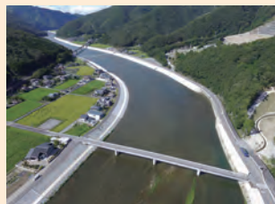
河道拡幅工事（千種川）
