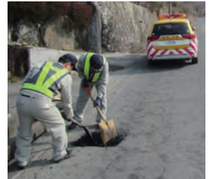
道路の補修作業
