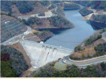
金出地ダム (上郡町金出地)
