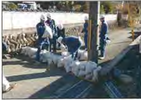
宍粟市 土嚢積み
