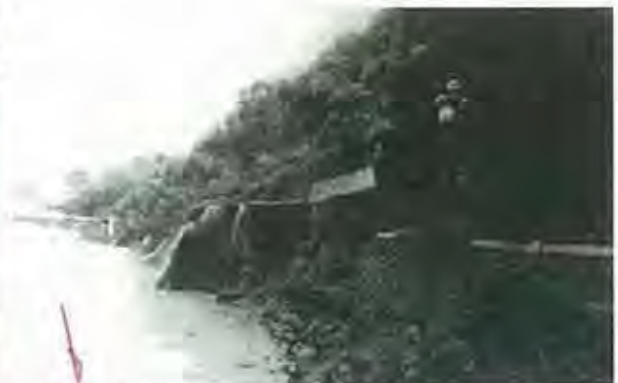
揖保川が氾濫し流失した県道 6 号線 (曲里付近)
