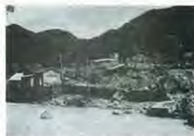
揖保川が土砂で埋没し流路が変わった状況 (宍粟市一宮町西深)
