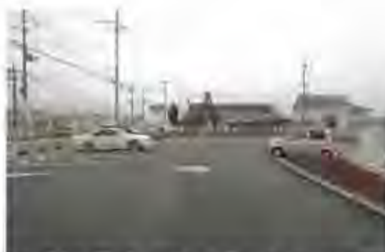
図 5-3 設置した指定雨水貯留施設
