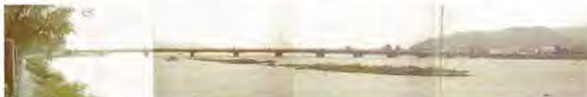
洪水中の龍野橋の状況 (たつの市)
