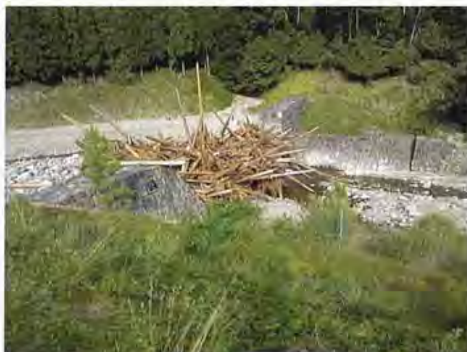
図 5-18 土砂・立木の捕捉状況(谷川砂防えん堤)平成21年8月
