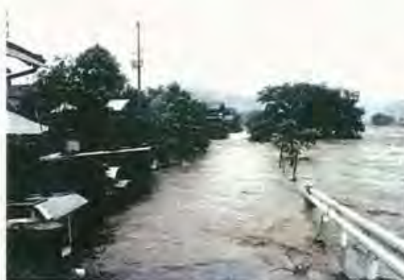
宍粟橋右岸浸水状況(宍粟市山崎町)
