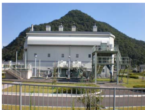
駅前雨水ポンプ場：上郡町
