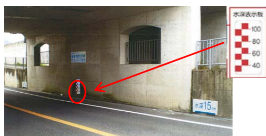
道路アンダーパスの水深表示板
