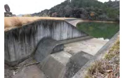
写真③ 洪水吐を改良したため池
