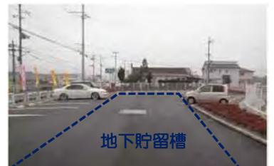
写真⑥ 指定雨水貯留施設の事例
