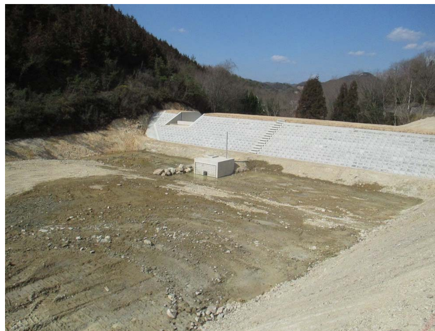
新池（施工状況）
