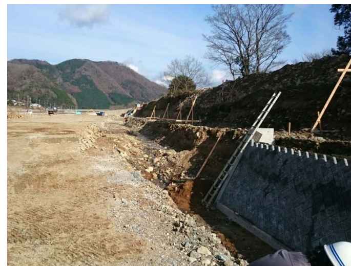
施工状況 (佐用町 久崎)
