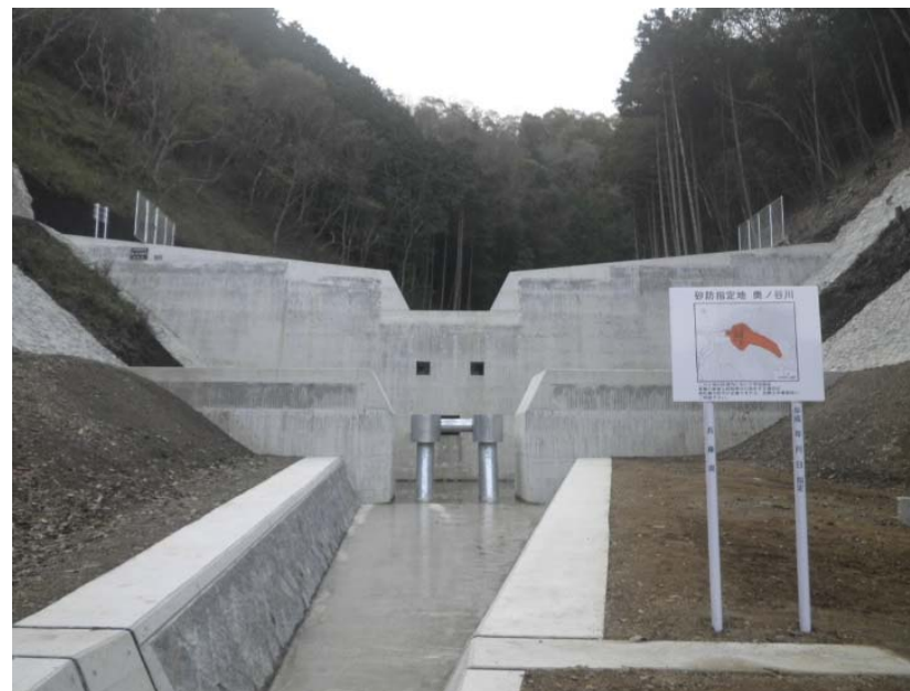
砂防えん堤(佐用町上石井)
