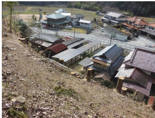
人家裏山の危険木伐採 (佐用町河崎地区)
