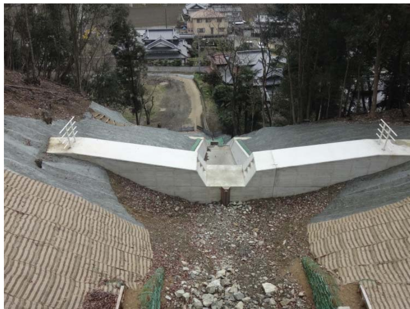
治山ダム(相生市矢野町小河)
