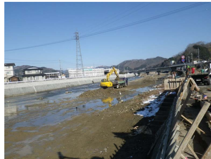
施工状況 (佐用町 大願寺)
