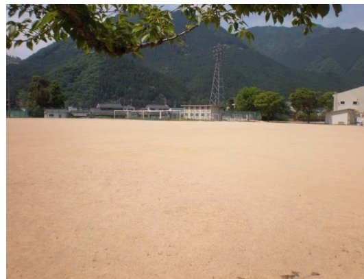
グラウンドを利用した雨水貯留
