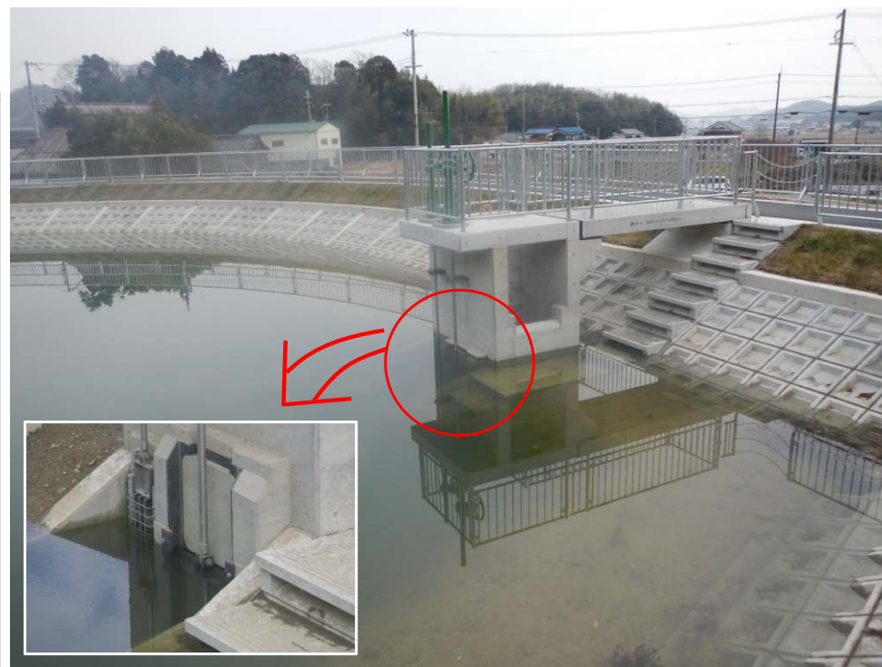
ため池の改修にあわせて、緊急放流設備を整備
