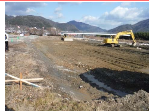
平成28年度の現場状況 (高水敷の掘削)
