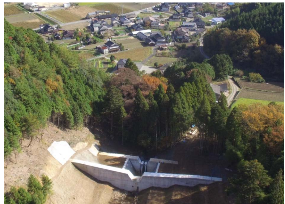
滝谷川 砂防えん堤(宍粟市山崎町中野)
