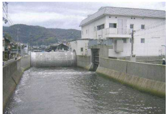
写真 1-11 大谷川（排水機場）
