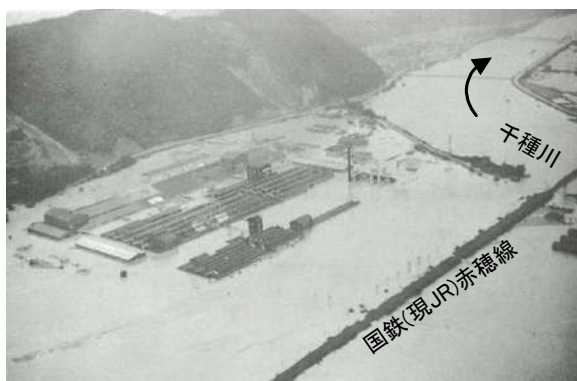
写真 1-6 S51.9 洪水の状況
