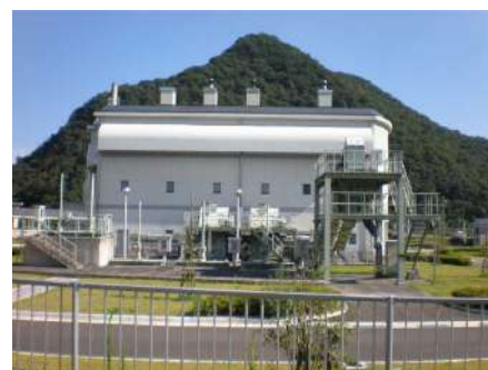
写真 5-4 ポンプ施設 (駅前雨水ポンプ場:上郡町)
