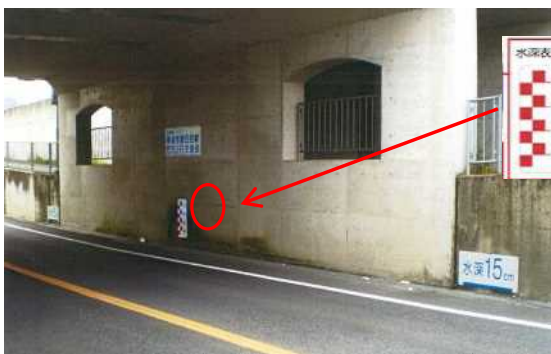
写真 6-2 道路アンダーパスの水深表示板 (主) 赤穂佐伯線 竹万 JR 交差点)
