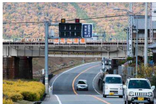
写真 6-3 冠水情報板 (国道 373 号 興井 JR 交差点)
