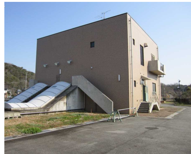
佐方ポンプ場
