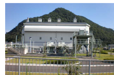
写真⑥ ポンプ場 (上郡町)
