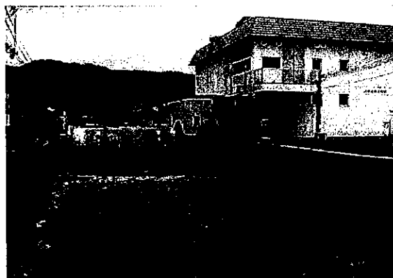
写真 1-11 大谷川（排水機場）
