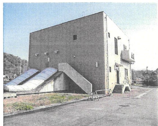
佐方ポンプ場
