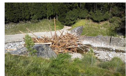
写真⑥ 土砂・流木の捕捉状況(宍粟市 谷川砂防えん堤)
