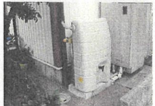
写真⑤ 各戸貯留施設の事例 (たつの市)
