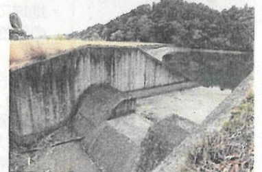
写真③ 洪水吐を改良したため池の事例(相生市 瓜生大池)
