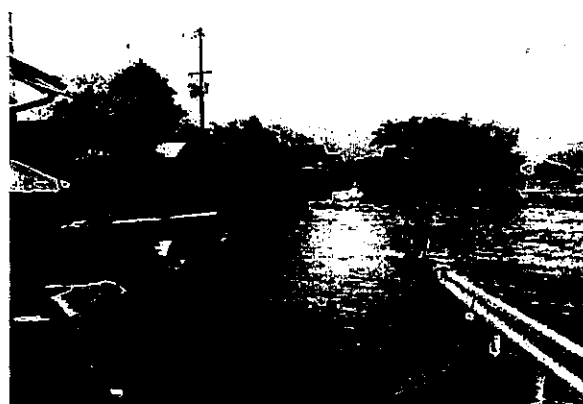
宍粟橋右岸浸水状況(宍粟市山崎町)
