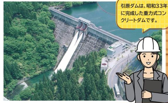
引原ダムは、昭和33年に完成した重力式コンクリートダムです。
