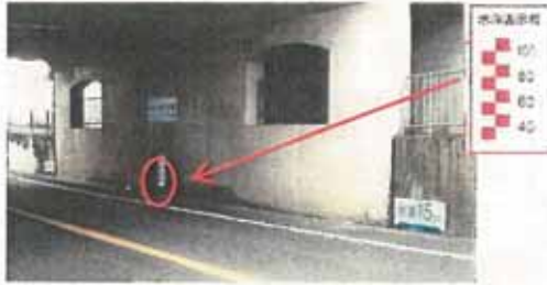
道路アンダーパスの水深表示板
