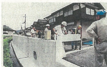
県西・北部豪雨で被害 佐用・真盛地区
