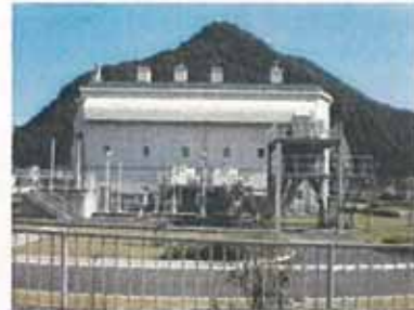
駅前雨水ポンプ場(上郡町)
