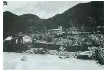
揖保川が土砂で埋没し流路が変わった状況(宍粟市一宮町西深)
