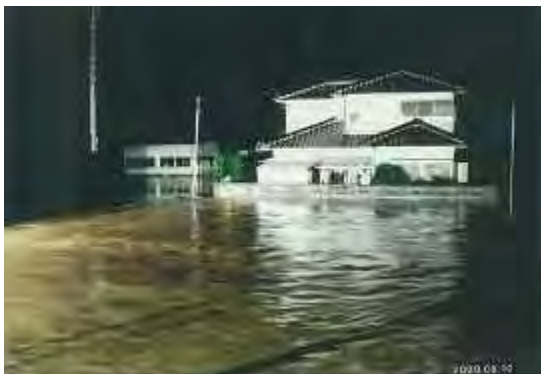
野田橋下流浸水状況(宍粟市山崎町)
