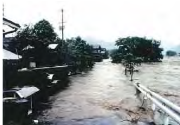
宍粟橋右岸浸水状況(宍粟市山崎町)
