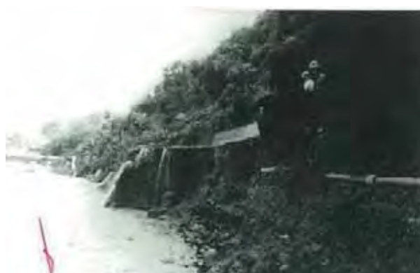
揖保川が氾濫し流失した県道6号線(曲里付近)
