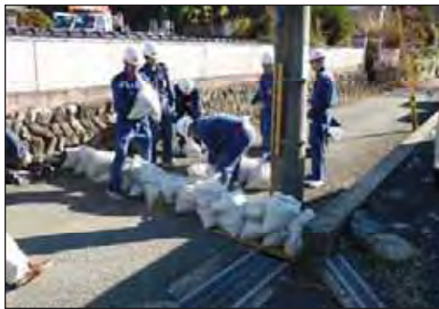
宍粟市 土嚢積み
