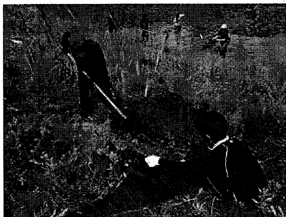
ため池法面の整地 7月
