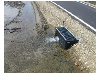
用水路をパイプライン化したほ場（丹波市）
