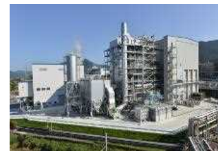
木質バイオマス発電施設(丹波市)
