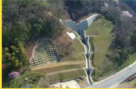
砂防えん堤(丹波市市島町徳尾)
