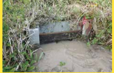
せき板設置状況
