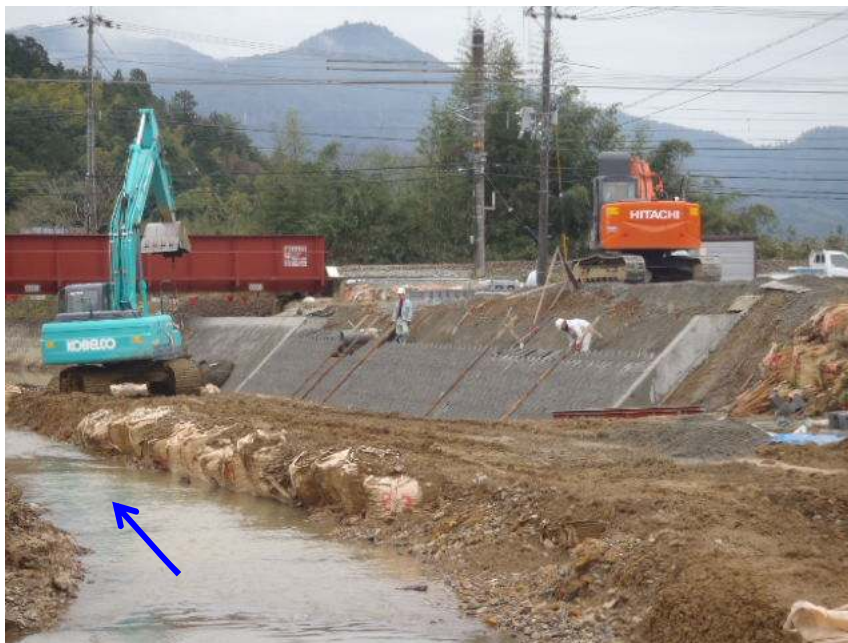
JR福知山線上流部 護岸工整備状況 (平成27年12月末)
