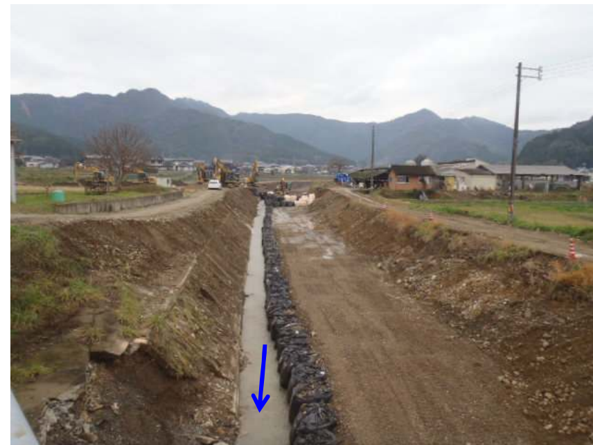
災害関連事業部 護岸工掘削状況 (平成27年12月末)
