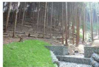
写真：溪流沿いの間伐及び簡易防災施設
