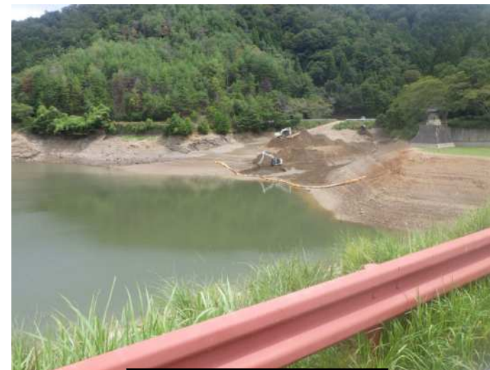
浚渫工事施工状況
