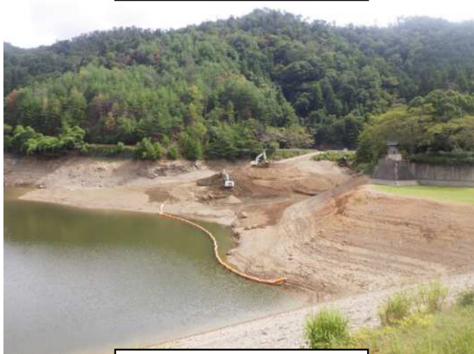
浚渫工事施工状況
