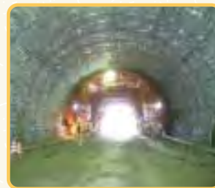
トンネル覆工
