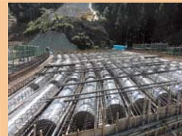
鉄筋の組立と円筒型枠の設置状況
