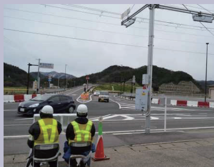
調査状況 (H30.12.11)
