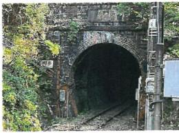
1911年(明治44年)に完成したJR山陰本線で当時最も長い全長1,991mの鉄道トンネル。JR山陰本線の中で最大の難所であり、当時の技術の中で最も近代的な工法が採用され、約4年間の歳月をかけ完成した。
