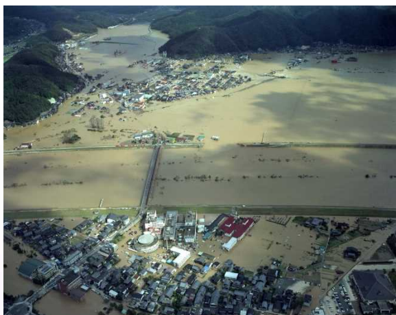
～平成16年台風23号による豊岡市街地の浸水状況～
