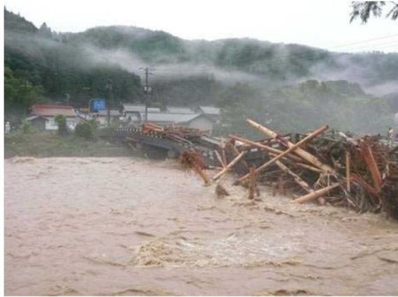
図 5.6.5 朝来市の神子畑川における流木による橋梁部の閉塞状況（2009（平成 21）年 8 月豪雨時）
