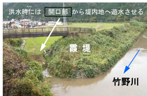
図 5.5.1 竹野川に現存する霞堤 (距離標 5 k 付近)
