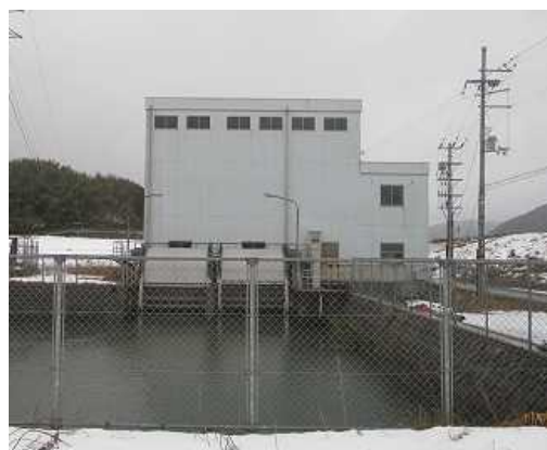
図 5.4.1 一日市排水機場（豊岡市、2001（平成 13）年完成）
