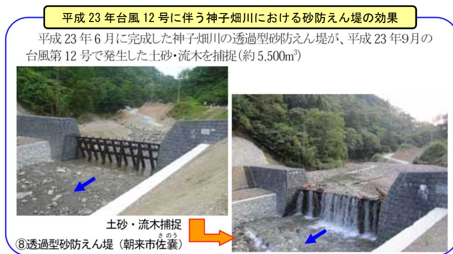
図 5.6.7 朝来市の神子畑川における砂防堰堤による土砂の捕捉状況（2011（平成23）年9月豪雨時）
