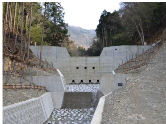
図 5.6.6 治山ダム さのう の例（朝来市佐囊）
