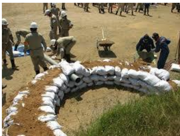
図 6.4.2 六方河川防災ステーションで行われた水防演習（月の輪工法）
