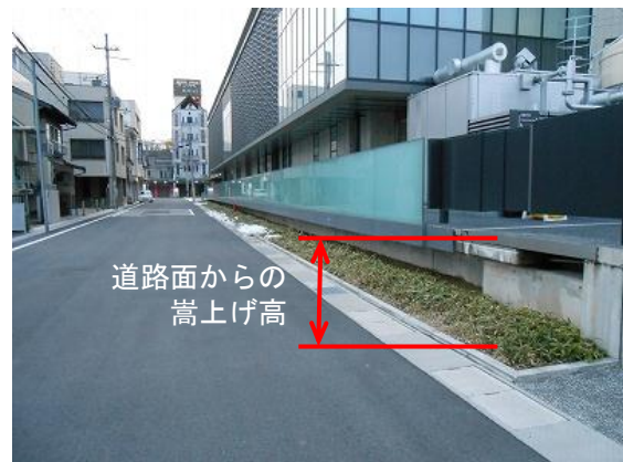
図 6.6.2 豊岡市役所の耐水化事例
