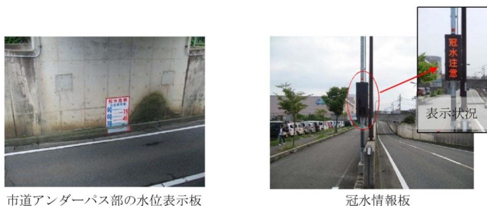
市道アンダーパス部の水位表示板 冠水情報板 図 6.2.9 豊岡市の市道におけるアンダーパスの冠水情報板・水深表示板の例 (市道 大開一日市線 西花園架道橋)
