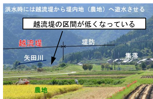
図 5.5.2 矢田川に現存する越流堤 (距離標 10.0 k 付近)
