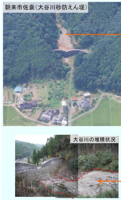
図 5.6.8 朝来市の大谷川砂防堰堤による土砂の捕捉状況 (2009 (平成 21) 年 8 月豪雨時)
