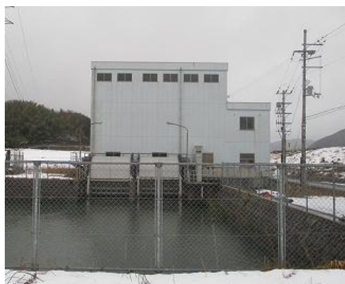
図 5.4.1 一日市排水機場（豊岡市、2001（平成13）年完成）
