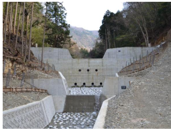
図 5.6.6 治山ダム さのう の例（朝来市佐囊）
