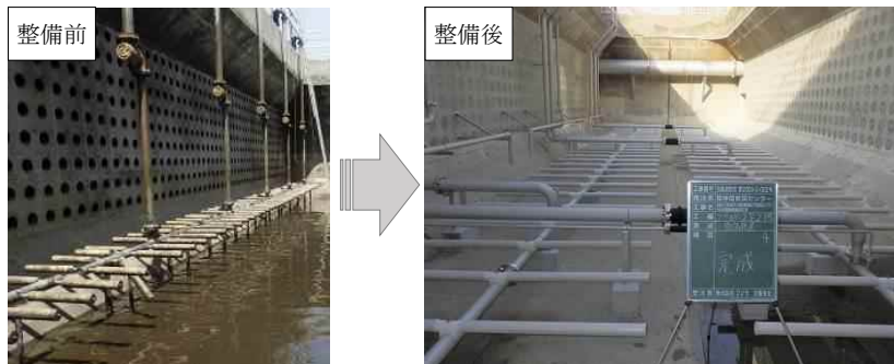
老朽化した散気装置を更新
