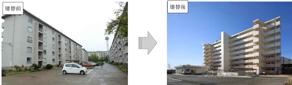
県営住宅の建替
