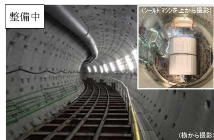
河川改修(地下貯留管)
