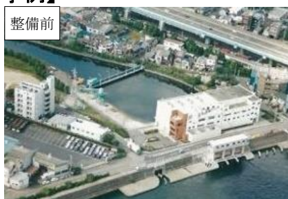
排水機場(更新)
