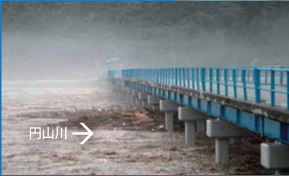
平成 21 年 8 月台風 9 号時の城崎大橋の状況
