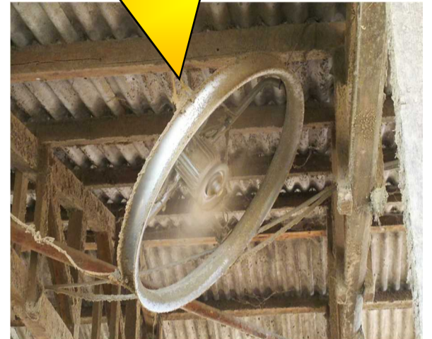
写真2 屋根に近接した送風ファンの設置例
