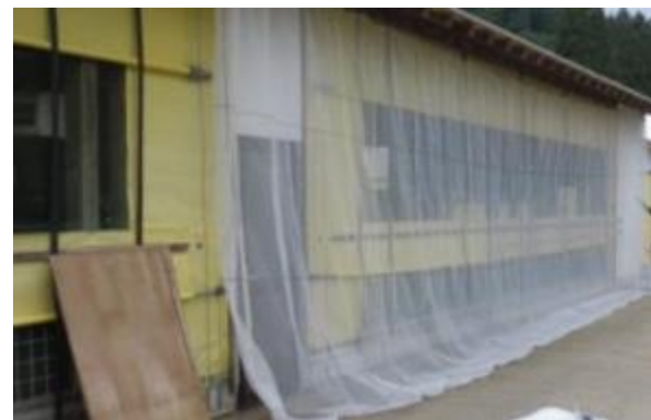
図5 ネット設置後
