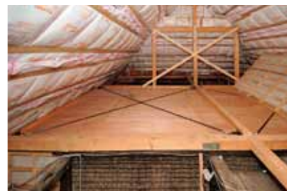
大改造!! 劇的ビフォーアフター「屋根が腐った家」内部写真
