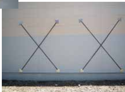
耐震ブレースX設置例
