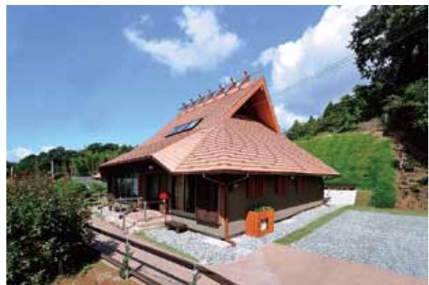
大改造!! 劇的ビフォーアフター「屋根が腐った家」
