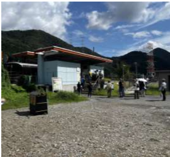
【千本駅駐車場整備（予定）】
