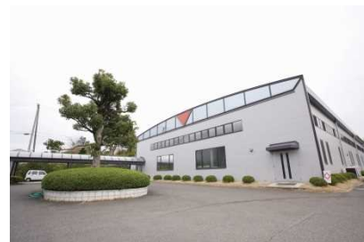
写真:工場外観
