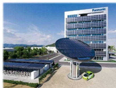
(蓄電池生産工場の集積)
