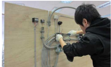
【電気配線実習】
