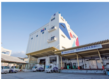
大阪湾工場(冷蔵庫棟)
