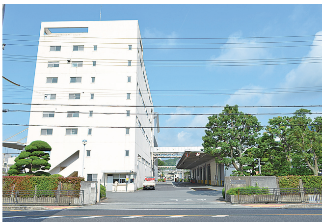
ヒガシマル醤油 第一工場正門
