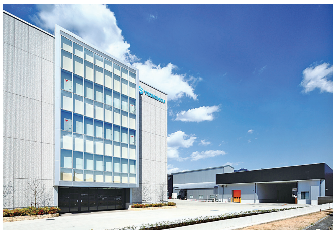
世界各地に向けてポンプを製造している本社工場の外観です
