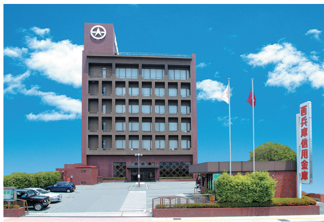
宍粟市山崎町にある本店建物
