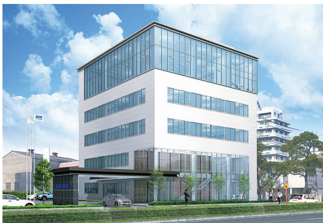
阿比野建設本社事務所
