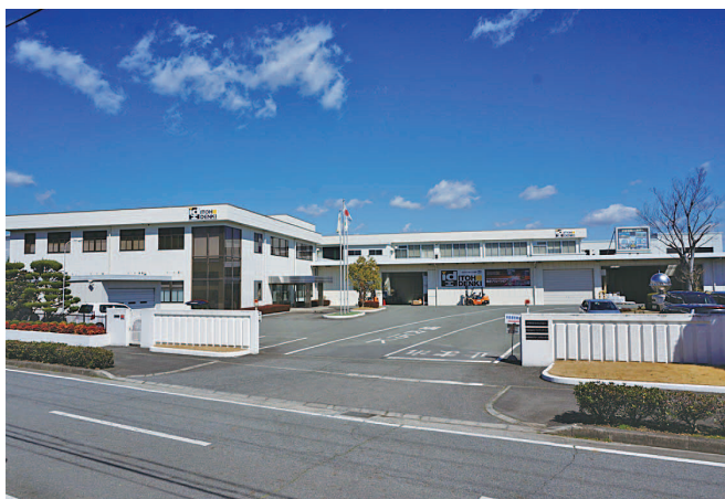
本社第一工場
