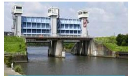
河川の排水機場・樋門を監視したり制御するためのシステムを開発
