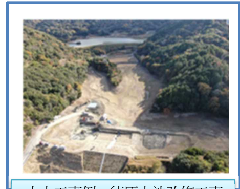
土木工事例：徳原大池改修工事
