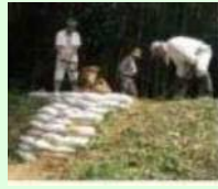
漏水箇所の補修
