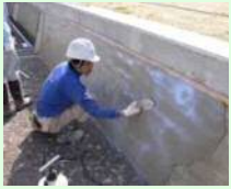
水路壁の表面被覆
