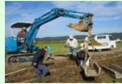
コンクリート水路の更新
