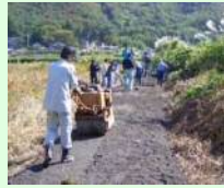
未舗装農道の舗装
