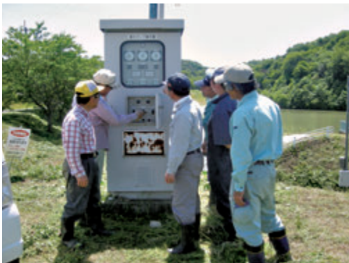
操作盤の点検
