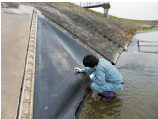
頭首工（ゴム堰）袋体 表面硬度診断
