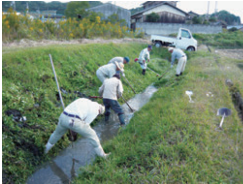
水路の草刈り、泥上げ
