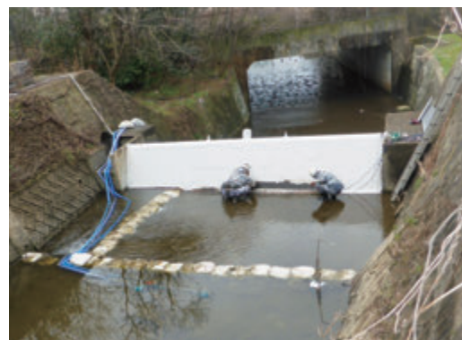
鋼製ゲート扉体の塗装
