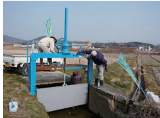
水路ゲートの塗装・清掃
