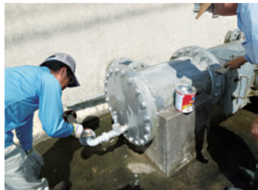
用水ポンプの配管の塗装
