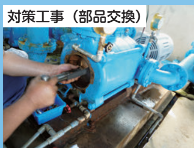
ポンプの部品交換
