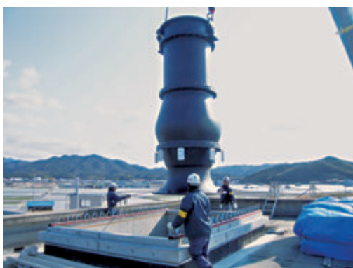
排水ポンプの更新
