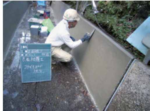
水路の表面被覆工法（無機系） ポリマーセメントモルタル
