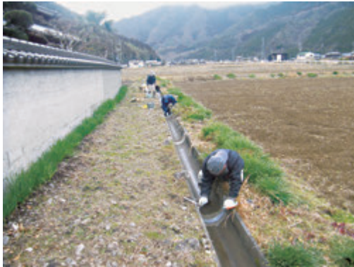
水路の目地補修（コーキング）
