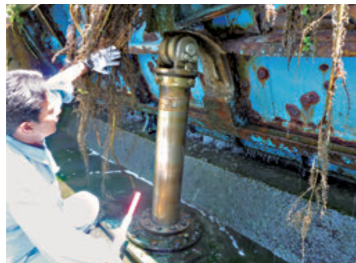
頭首工（鋼製）ゲートの 油圧シリンダー点検確認
