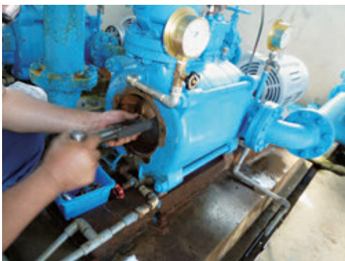
用水ポンプの部品交換
