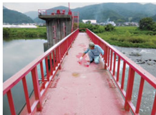
頭首工管理橋の塗装
