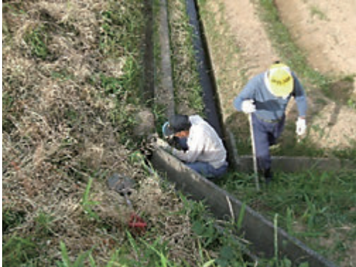
水路の目地部の点検
