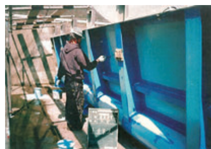
頭首工（扉体）の塗装
