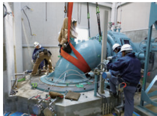
排水ポンプの分解・更新
