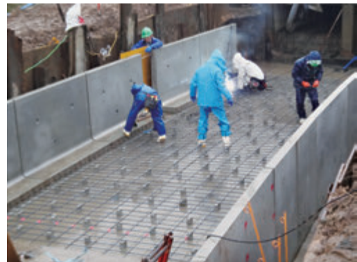
基幹的な水路の更新 (L型水路 + 底張りコンクリート)
