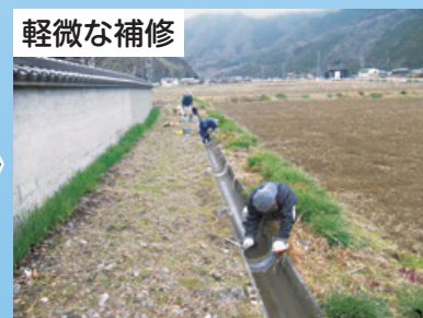
水路の目地補修
