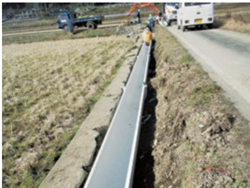
小規模な水路の更新 (鉄筋コンクリートフリユーム)
