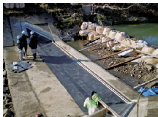
頭首工（ゴム堰）袋体の水密ゴムの更新
