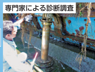
頭首工の調査
