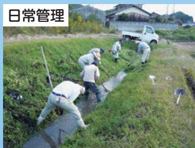
水路の草刈り、泥上げ
